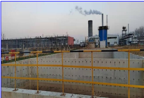
现有工程前期雨水池和事故水池
