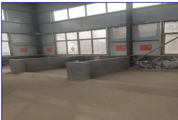
现有工程危废暂存间
