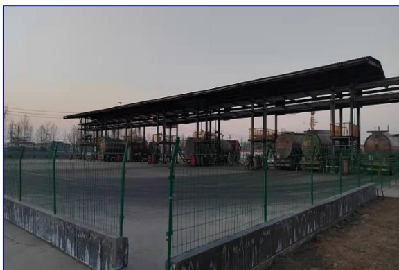
现有工程装卸车区
