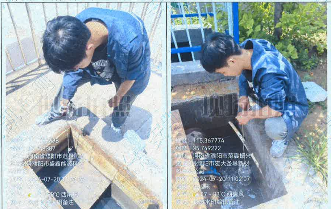
附图 1：现场检测照片
