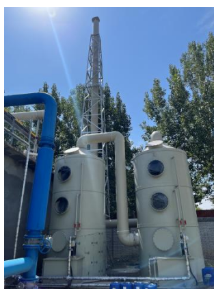
污水处理站废气处理：水洗+生物净化
